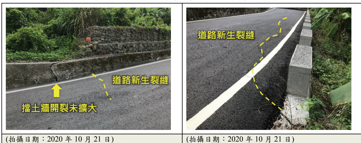
圖2、樣子寮地區潛在山崩地區現場勘查成果。道路略有新生裂縫(本計畫彙整)
