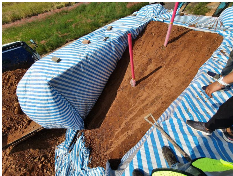
圖 4 現場人工邊坡鋪設完成情形
