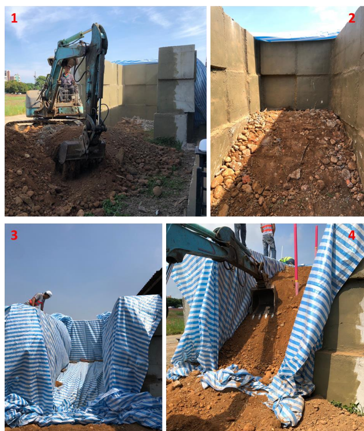
圖 3 土槽現場配置情形
