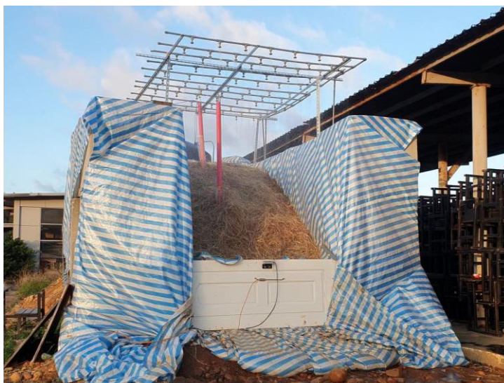
圖 10 架設完成後現場灑水測試
