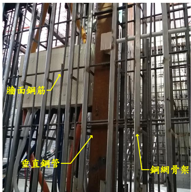
鋼管、鋼筋及骨架
