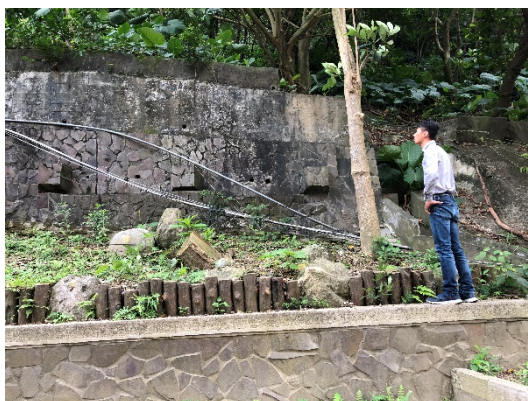
(5)觀星台北社區地錨擋土牆
