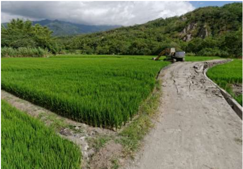
圖 9、富里鄉南側，富池橋附近稻田中，池上斷層活動引致地表破裂，向東
