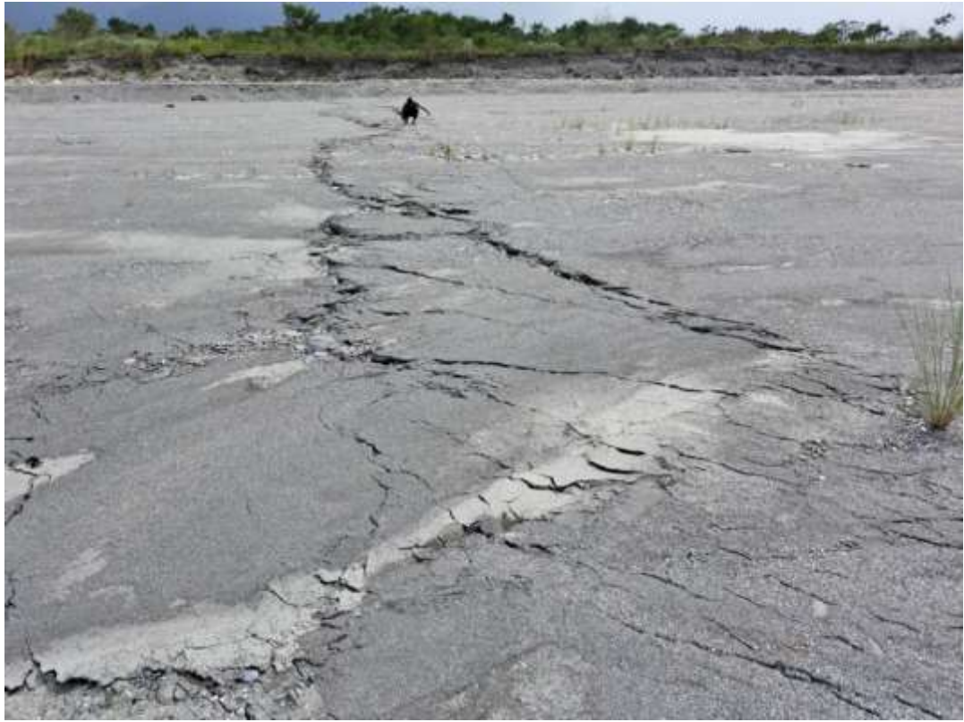
圖 8、拉庫拉庫溪（樂樂溪）河床，玉里斷層活動所造成的地表破裂，向南拍攝。
