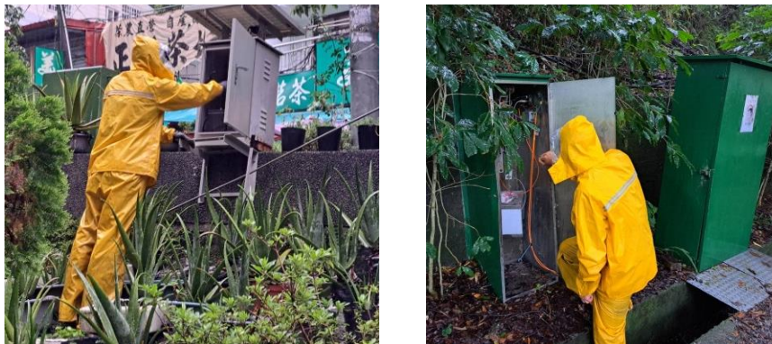
圖 6、自動化活動性觀測站維護情形(以廬山溫泉北坡為例)
