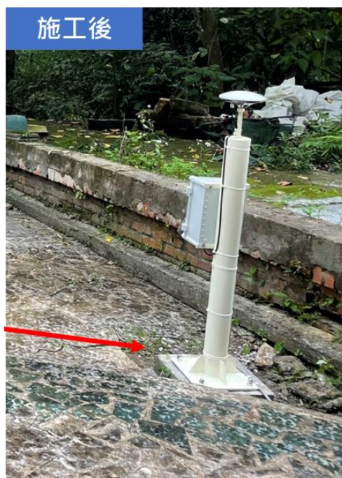
圖 4、GNSS 測站完工照
