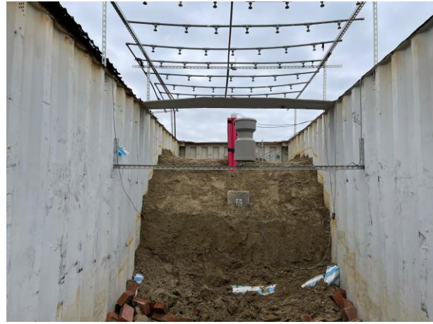
(b)砍坡腳自然邊坡
