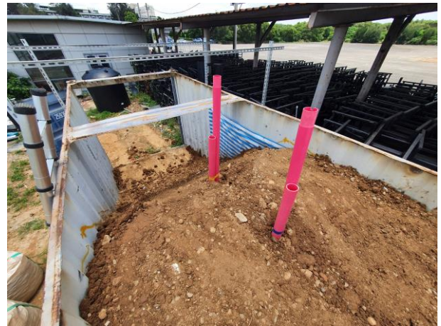
圖 2 大尺寸試驗模型傾斜管埋設完成
