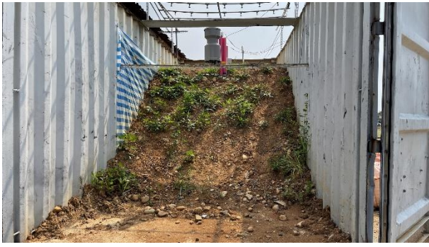
(a)未砍坡腳自然邊坡
