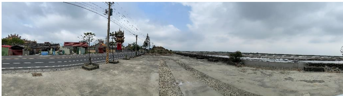
圖 5-9 頂山里東側村落圍堤
