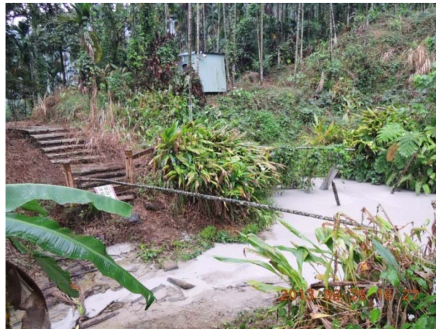
圖 2-4.8：中崙濁水潭觀測站野外現地照片，圖中顯示測站與潭水之間的距離逐漸接近，有崩塌之疑慮，現已改裝為溶解氣體觀測站。
