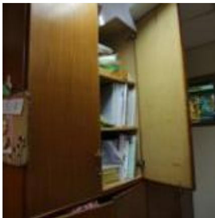
圖 5、高櫃是固定式的，但地震時門易打開、內部物品易掉落出來
