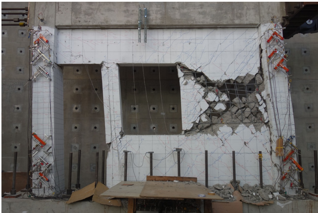
圖 4 試體 4 最終破壞情形
