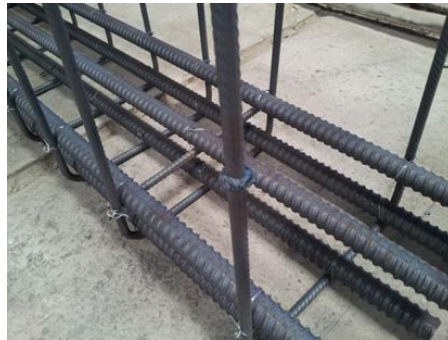
圖 13、焊接箍筋
