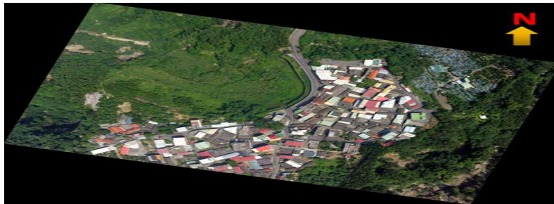
圖 11、空拍雲林坪頂山坡崩塌潛勢區之 RGB 正射影像彩色照
