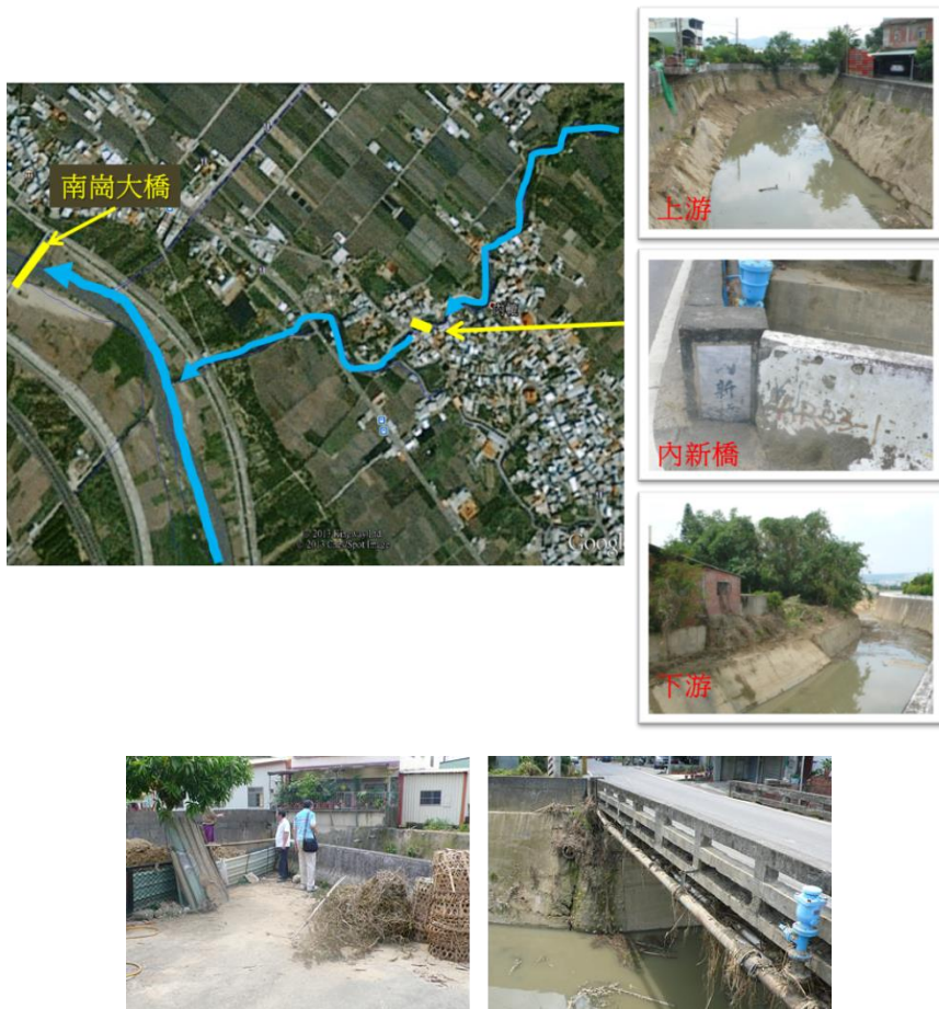
圖 5. 內新里內新橋貓羅溪外轆排水現勘照片(照片拍攝日期：7/24)
