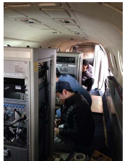
圖 2 SAR 設備安裝情形
