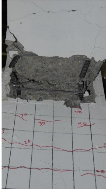
圖 11 梁編號 RB3 於位移比 8% 時梁底主筋產生斷裂之情形
