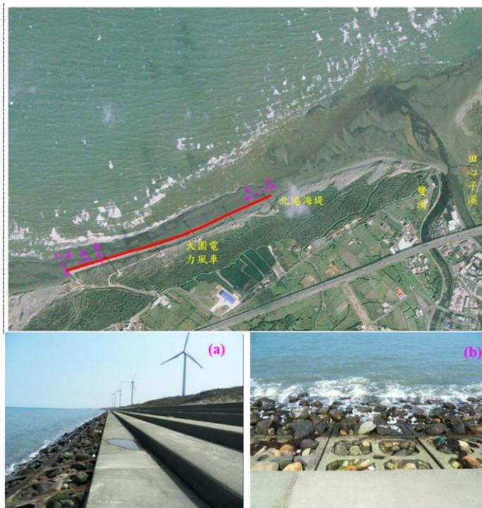
北港海堤，總長約1.1km，堤高約5.0m。整段堤線皆平行海岸線而無轉折，沿線堤型亦無變化(a)，屬階梯式混凝土堤，靠海側則以混凝土框條內拋石為保護。
