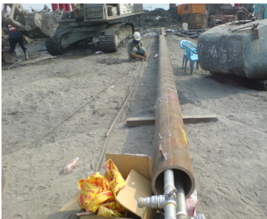
圖 5、冲刷監測管現地組裝(鋼套管)
