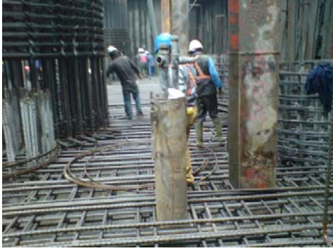
圖 7、沖刷監測管現地工序(配合基礎底板施工)
