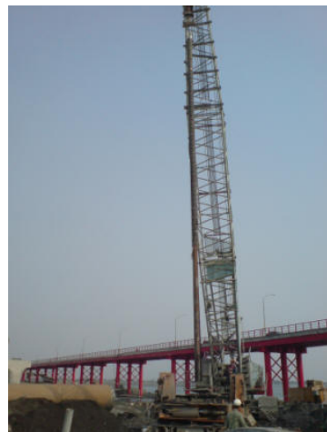
圖 6、冲刷監測管現地吊裝作業
