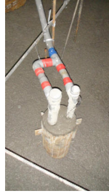
圖 8、沖刷監測管現地配管(配合基礎底板灌漿)
