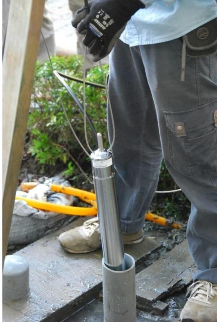
圖 9：宜蘭國小示範站 40m 深井式地震儀設置照片
