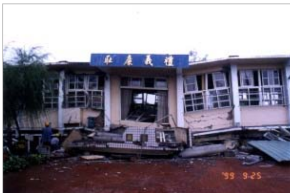
校舍震害照片
