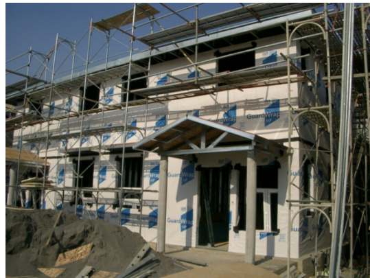
圖 3 輕鋼構建築(永久安置屋)
