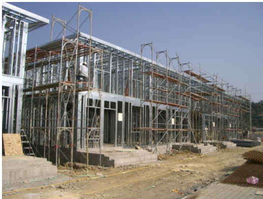
圖 3 輕鋼構建築(永久安置屋)
