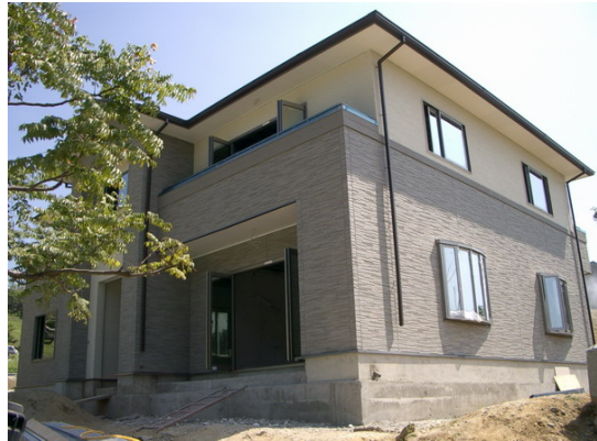
圖 2 輕鋼構建築(一般住宅)
