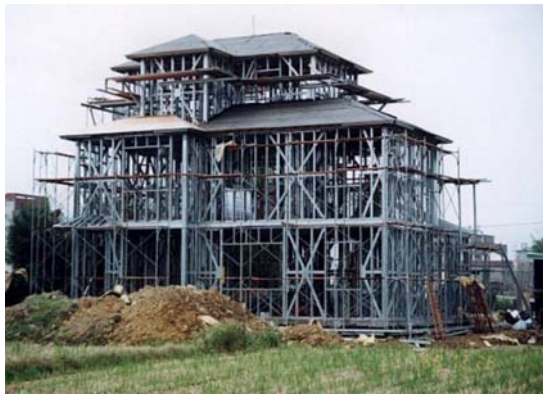
圖 1 輕鋼構建築(農舍)
