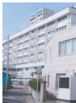
(a) 醫院建築採外附式鋼斜撐框架補強
