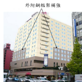
(b) 商辦大樓採外附式鋼框架補強
