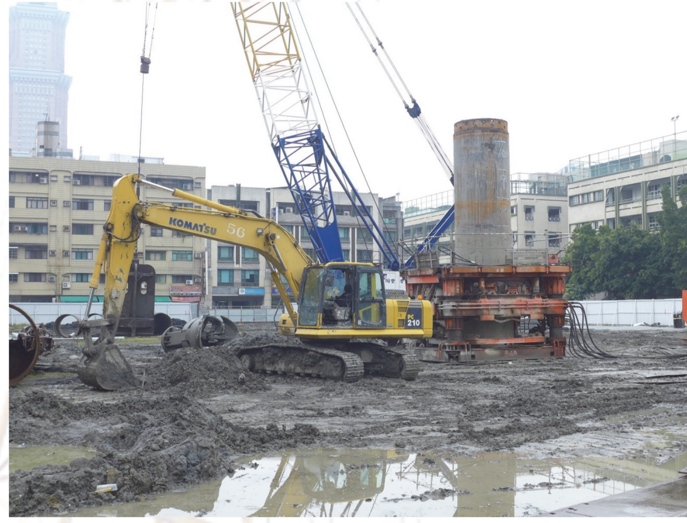
清障工法：全套管切割施工
