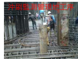
橋墩樁帽上部沿橋墩配置回填覆土之冲刷及水位監測管
