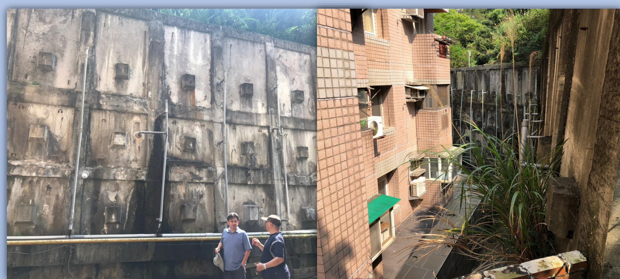
觀天下社區擋土牆現勘
