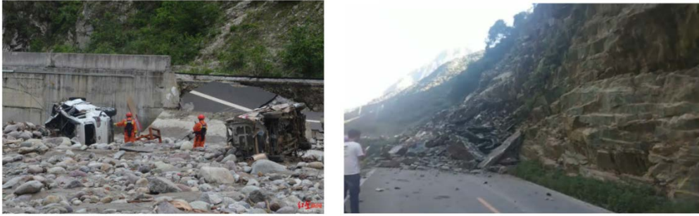
圖 17、冕寧高速路口 248 國道因路基流失，路面坍塌道路中斷
