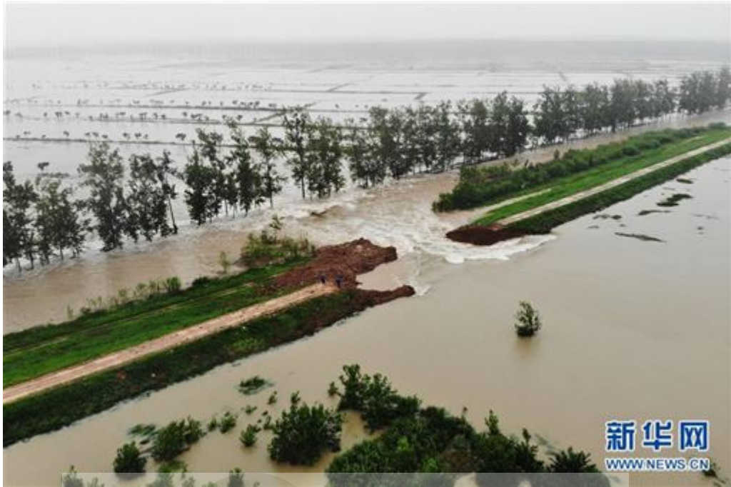
圖 15、安徽滁河大堤破開兩處缺口
