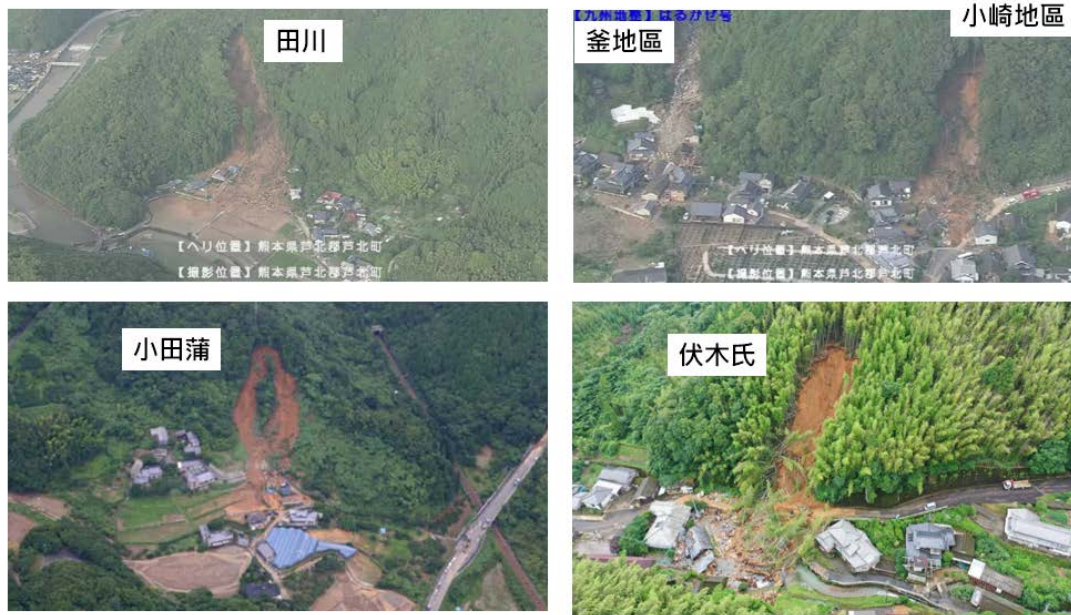
圖 33、蘆北町境內崩塌照片
