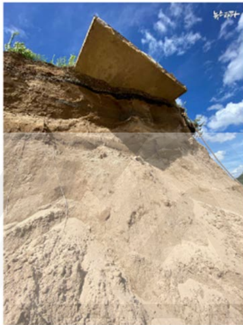
圖 43、洛東江上游潰決沙製路堤切面[45]
