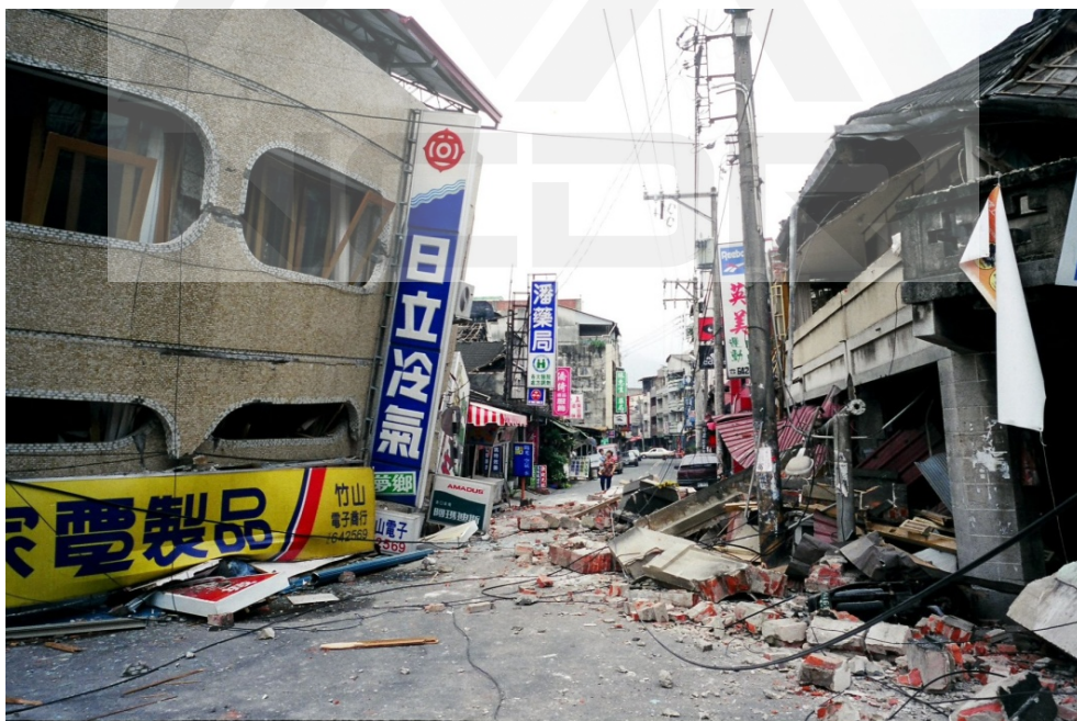
圖 35、南投民宅倒塌道路損壞
