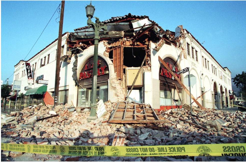
圖 28、建物倒塌大量碎屑散落
