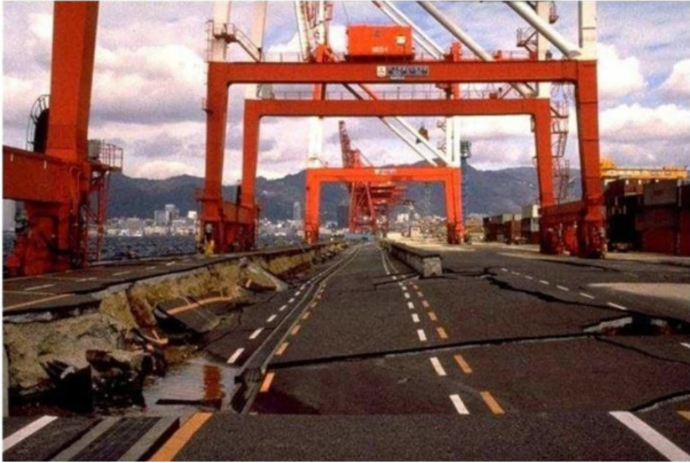
圖 31、神戶港受土壤液化道路損壞塌陷
