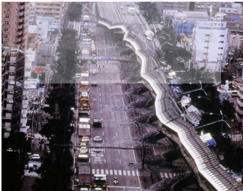
圖 30、阪神高速公路坍塌
