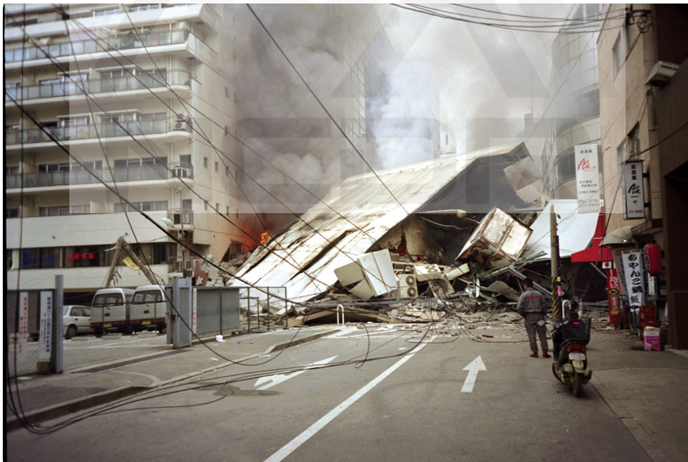
圖 32、建物嚴重倒塌起火
