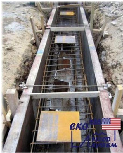
圖 3-15 河岸防護之水工構造物防滲處理
