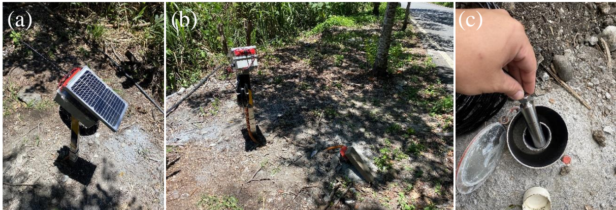
圖 4.1.2-17 109-WL-5W 即時水位監測站與監測孔位完工實況
