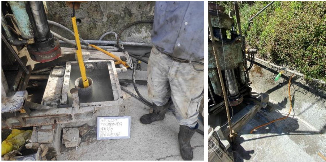
圖 4.1.2-7 109-WL-4T TDR 監測纜線安裝現況 (TDR 剪動監測)
