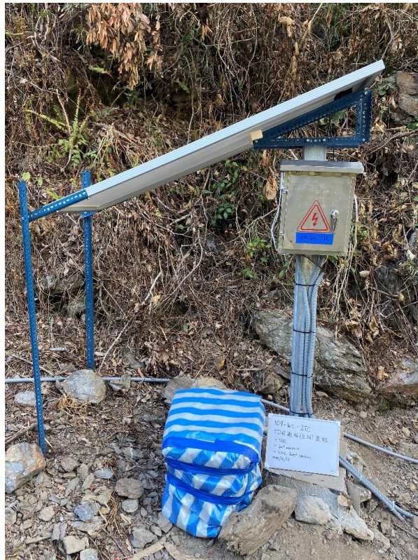
圖 4.1.2-8 109-WL-2TC 監測儀器箱安裝現場配置 (TDR 剪動監測)
