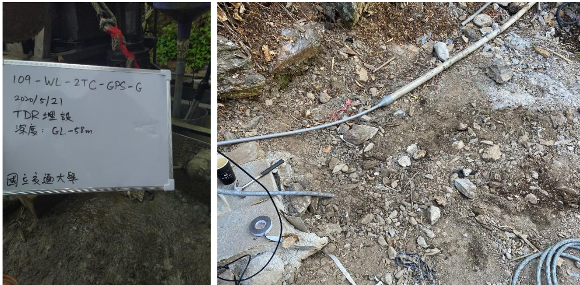
圖 4.1.2-6 109-WL-2TC TDR 監測纜線安裝現況 (TDR 剪動監測)
