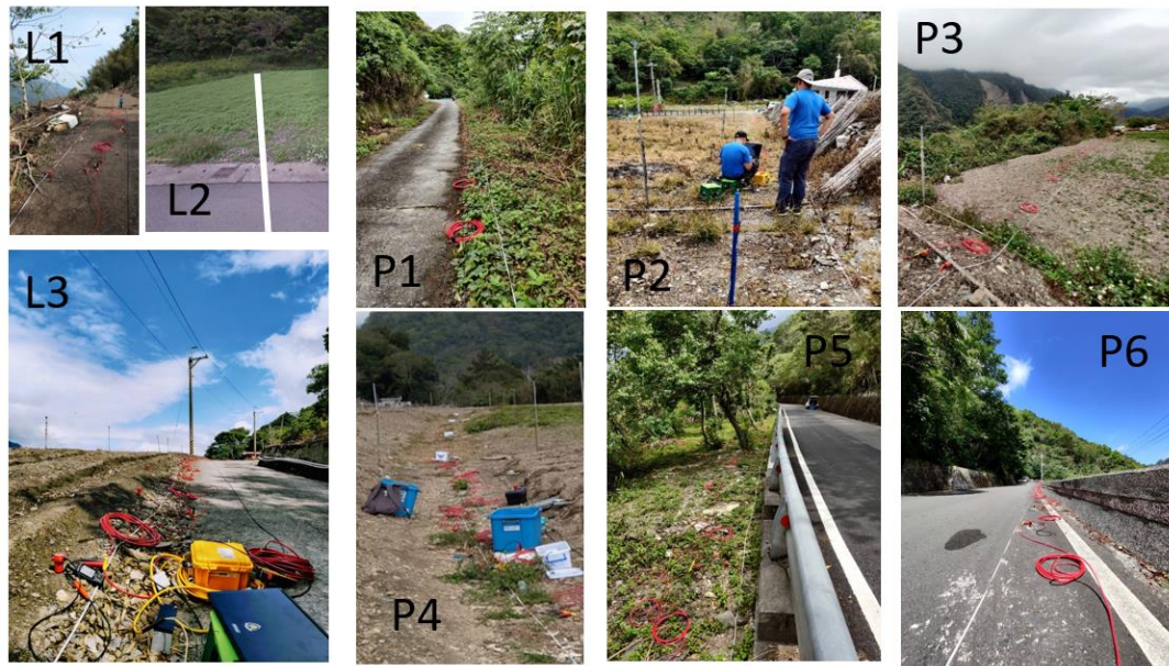
圖 2.1.5-2 表面波震測現場施作狀況
