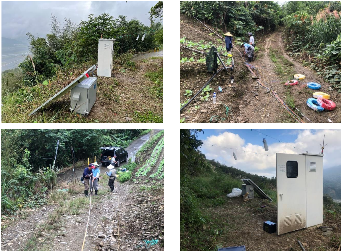
圖 6.2.4-7 時序地電阻影像現場佈設照片圖
