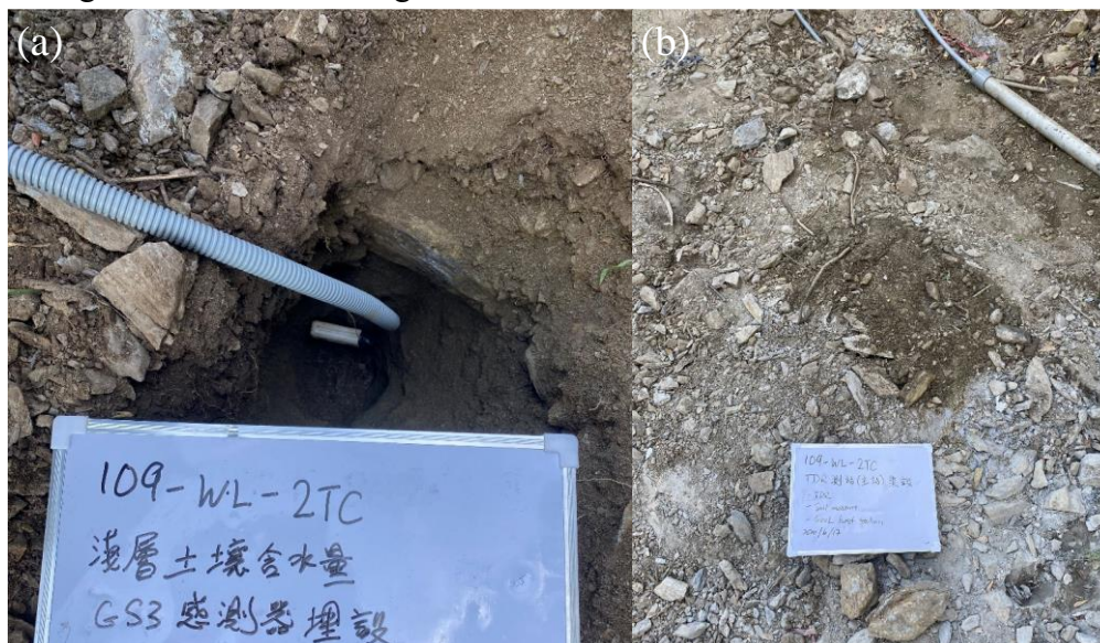
圖 4.1.2-11 109-WL-2TC 淺層含水量監測(a)安裝過程實況; (b)完工實況
