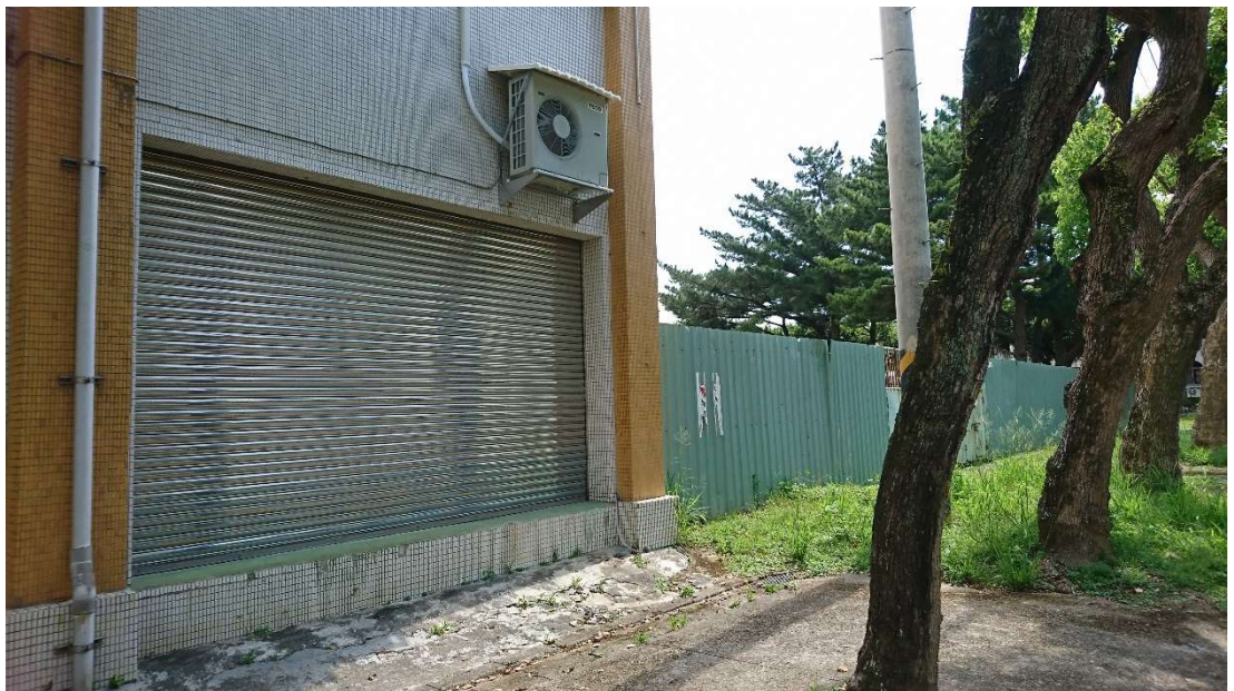
圖 2 輻災防救訓練研發中心基地原有外牆及大門
