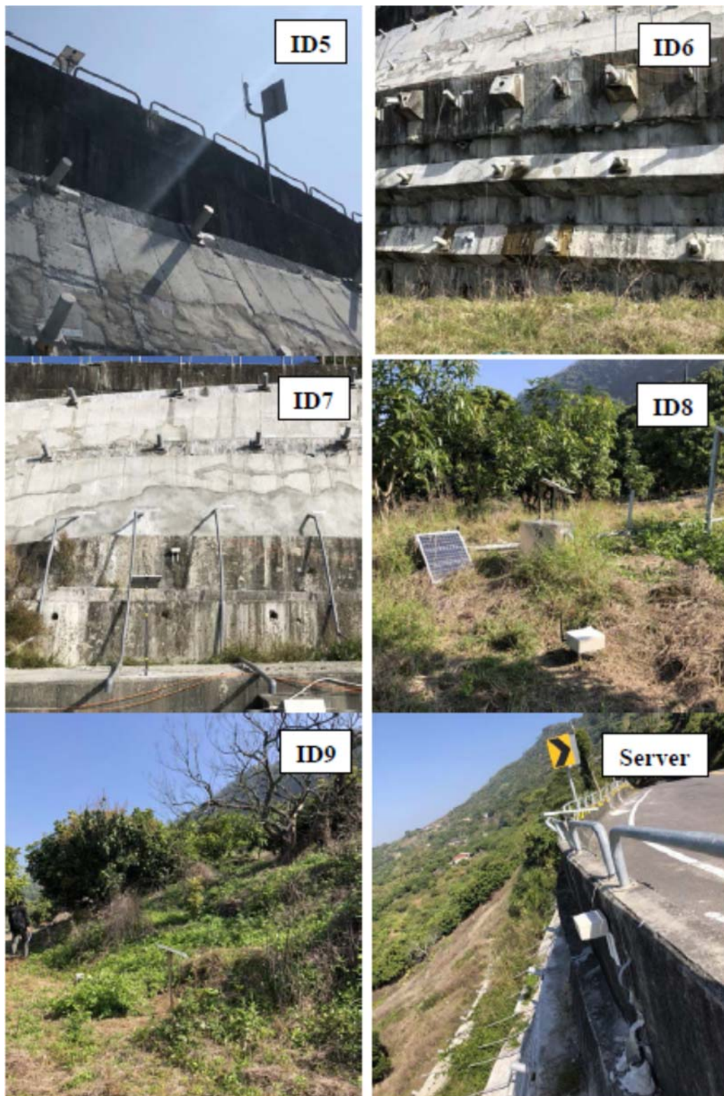
圖 5.25 南市道 175 線場址監測模組現場架設圖(2/2)
