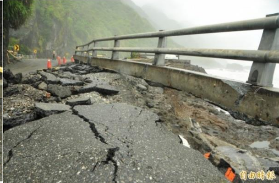
台11線道路中斷，路基被蘇迪勒颱風帶來的巨浪挖空。(記者花孟環攝)
