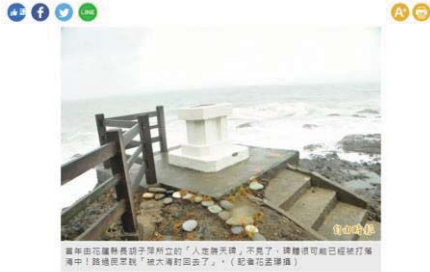
2015-08-08 11:55:02 【記者花孟瑋 / 花蓮報導】蘇迪勒颱風掃過花蓮東海岸，花蓮鹽濱鄉台11線62.1K「人定勝天碑」路旁，有40公尺護路牆基流失，就連當年台11線鄉道時所立、突出海面的「人定勝天」碑都被大浪打到不見蹤影！
