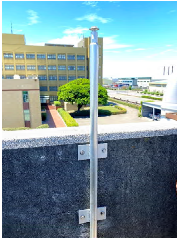
圖 3-65 GNSS 靜態基站施工建置完成
