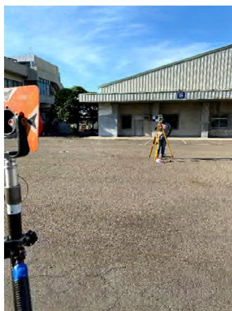
圖 3-68 校正標位置測量—全測站儀測量校正標坐標
