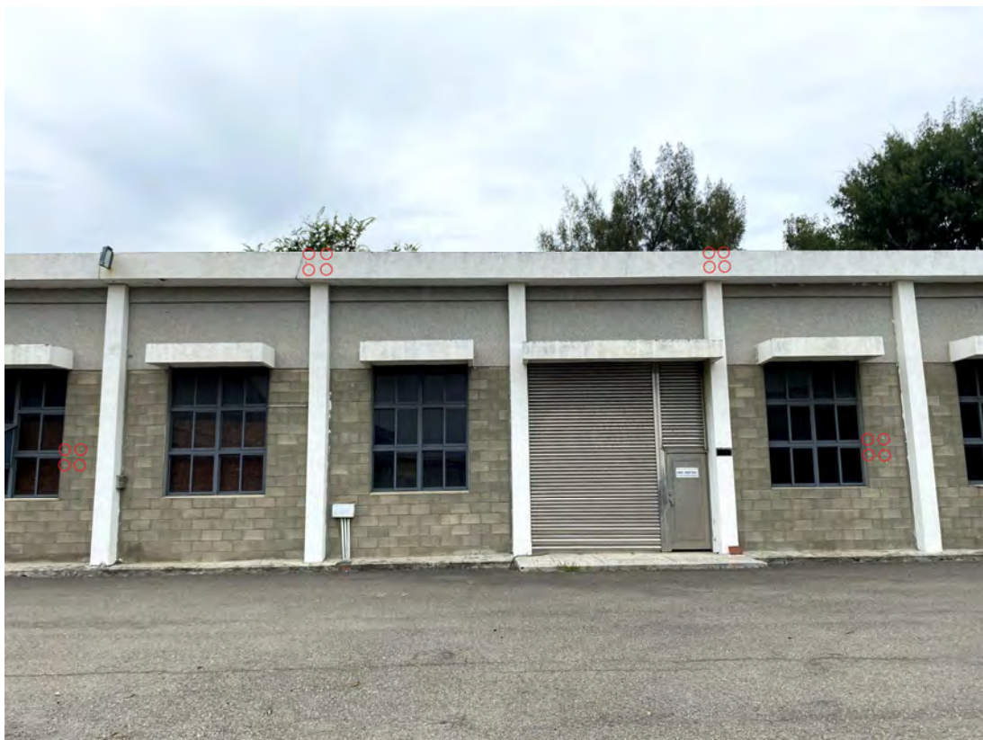
圖 3-50 牆面磁鐵施工建置完成（東側建物）
