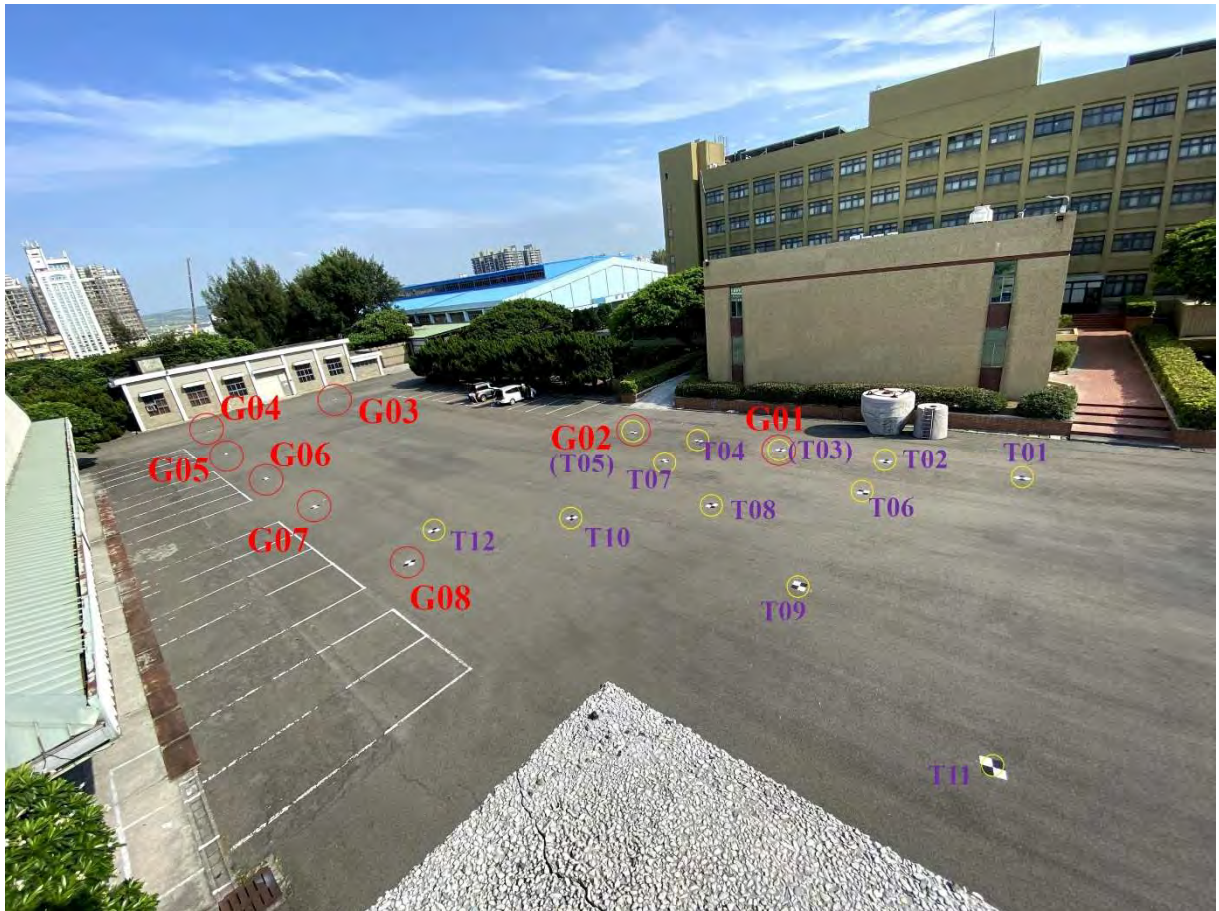
圖 3-58 地面校正標施工建置完成 (含率定標)
