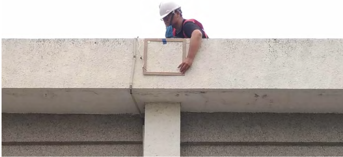
圖 3-48 使用高空作業護具於女兒牆外貼附牆面磁鐵
