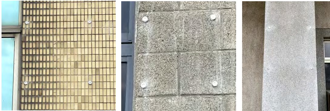
圖 3-52 牆面磁鐵施工建置完成—細部檢視
