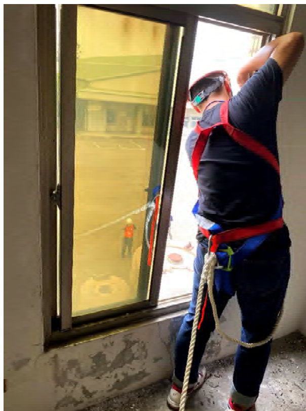
圖 3-47 使用高空作業護具於窗戶外貼附牆面磁鐵
