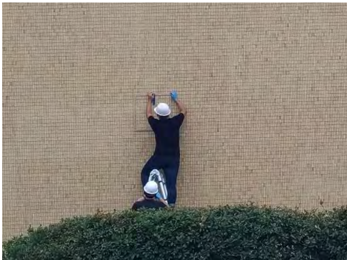
圖 3-46 使用摺疊安全梯貼附牆面磁鐵
