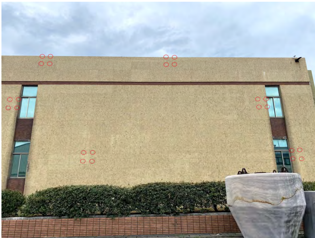
圖 3-49 牆面磁鐵施工建置完成（南側建物）
