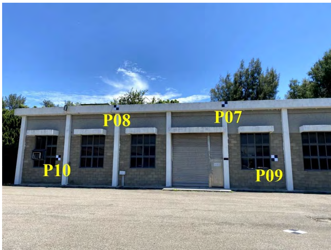
圖 3-54 牆面校正標安裝完成（東側建物）
