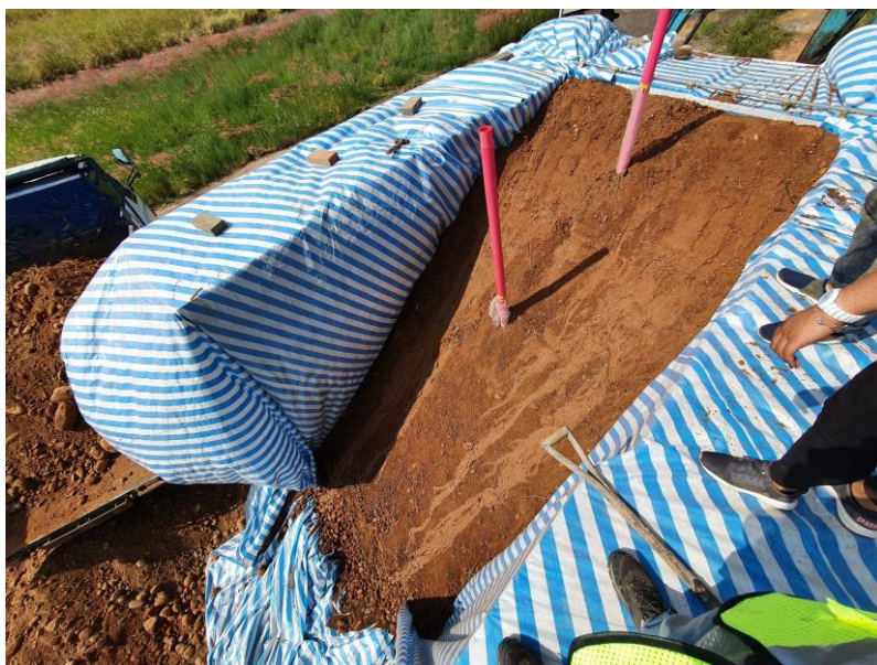
圖 3.1-4 現場人工邊坡鋪設完成情形
