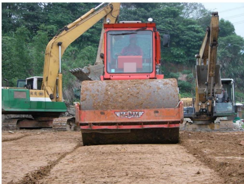
圖 2.4-3 大尺寸加勁擋土牆構築過程所需之大型機具滾壓(楊錦裕 2004)
