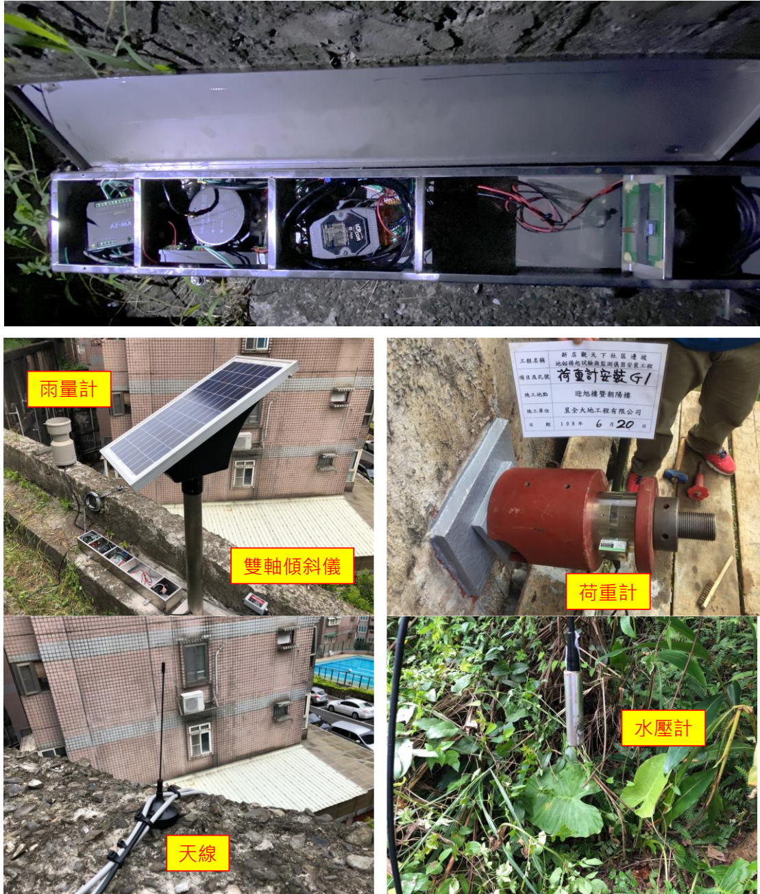
圖 2.2-2 現場監測儀器裝設完畢後照片
