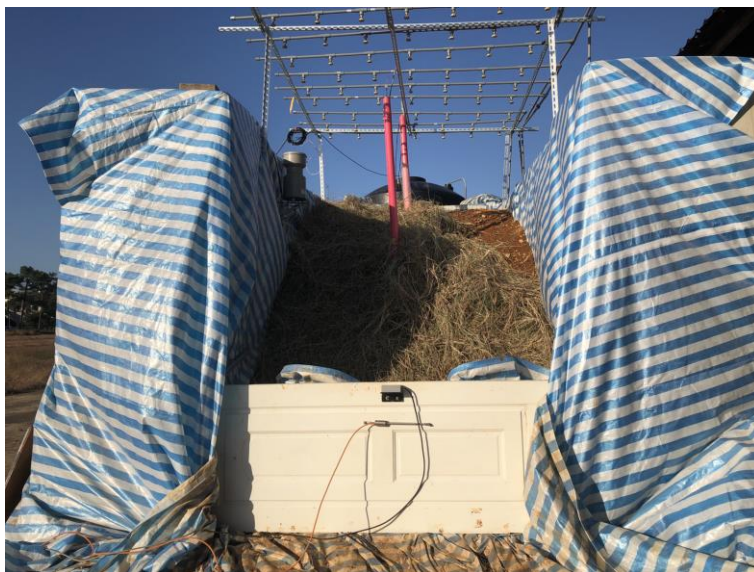
圖 3.2-10 現場設備裝設完成
