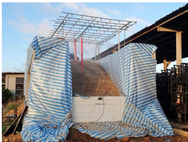
圖 4.2-3 架設完成後現場灑水測試
