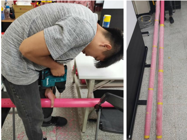
圖 3.2-8 傾斜管於埋設前進行開篩
