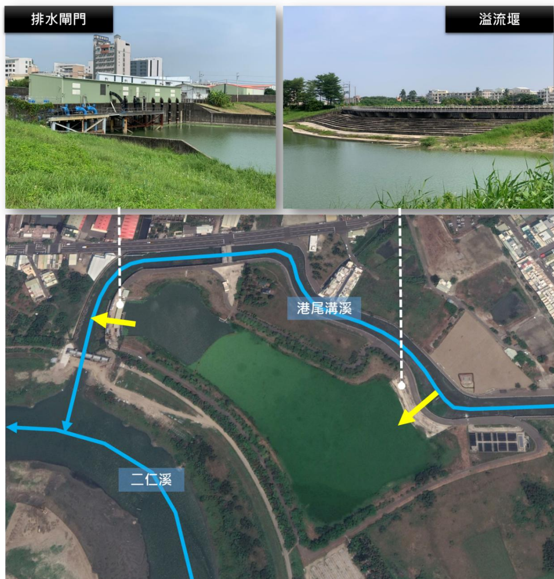
圖 2-17 港尾溝滯洪池進出口型式流向及現勘照片
