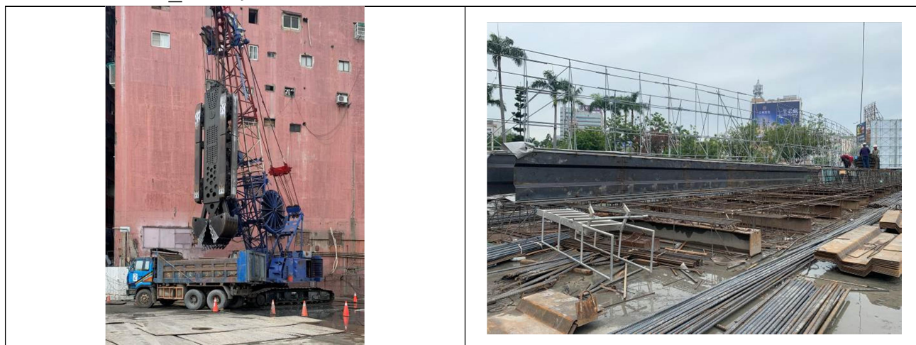
編號：01 說明：連續壁工程挖掘式掘削機施工
