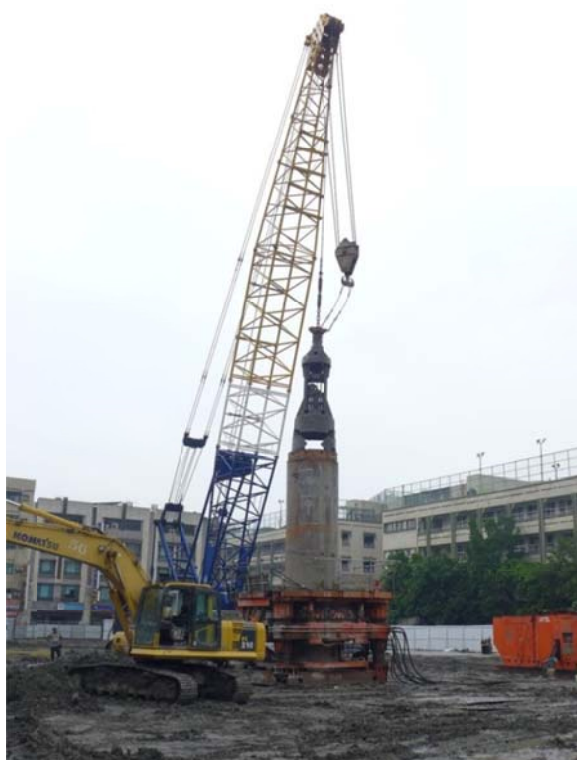
圖 2-3 全套管搖管機 (研究團隊工地參訪照片)
