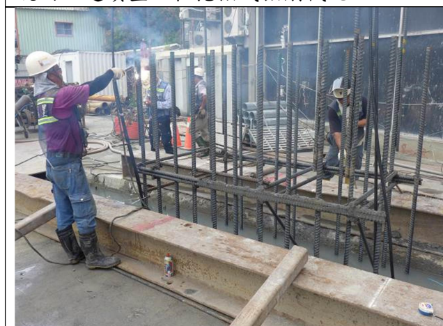
編號：03 說明：連續壁鋼筋籠吊放及定位
