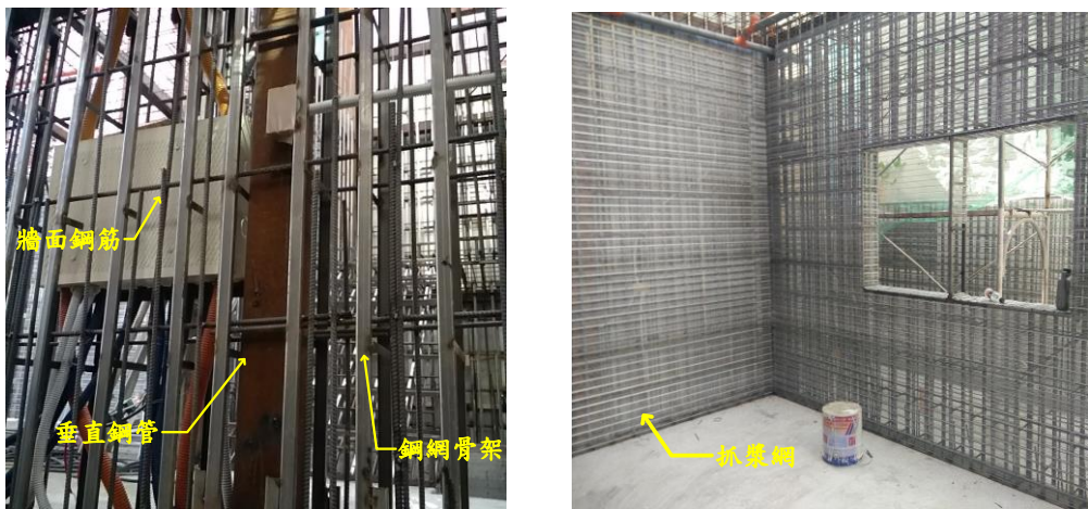
(a) 鋼網骨架及牆面鋼筋配置情況
