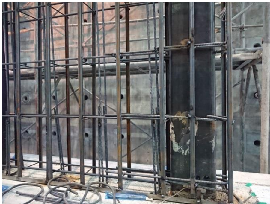
圖 3.14 鋼網骨架及牆面鋼筋架設 (資料來源：本研究製作)
