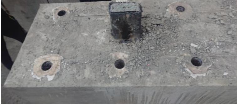
圖 4.24 2×2 試體鋼管內混凝土填充狀況
