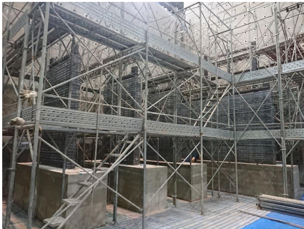
圖 3.16 鋼網牆製作完成 (資料來源：本研究製作)
