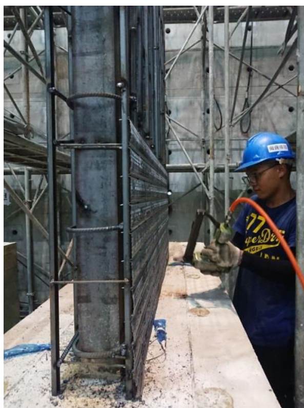
圖 3.15 打設抓漿 (資料來源：本研究製作)
