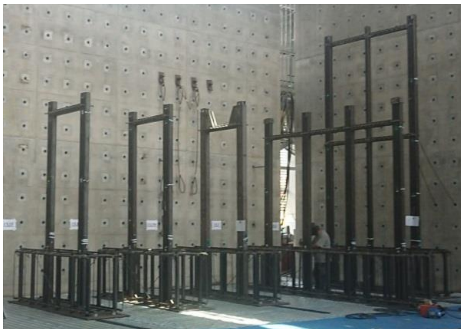
圖 3.12 鋼管骨架完成 (資料來源：本研究製作)
