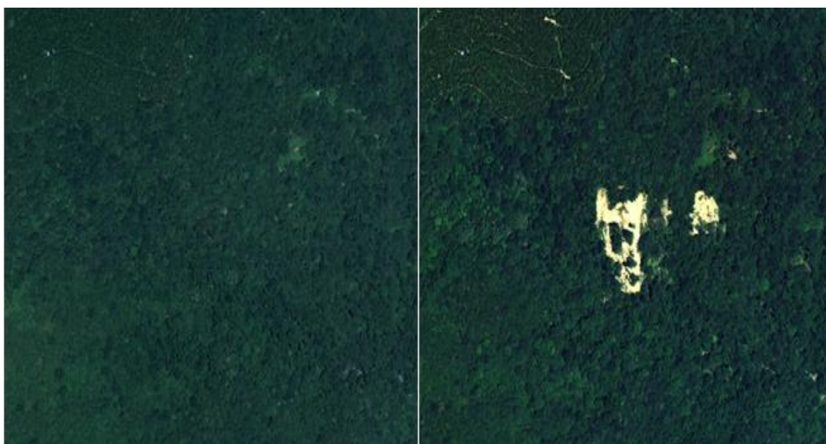
圖 4.3-12、崩塌前(左)後(右)航拍影像
