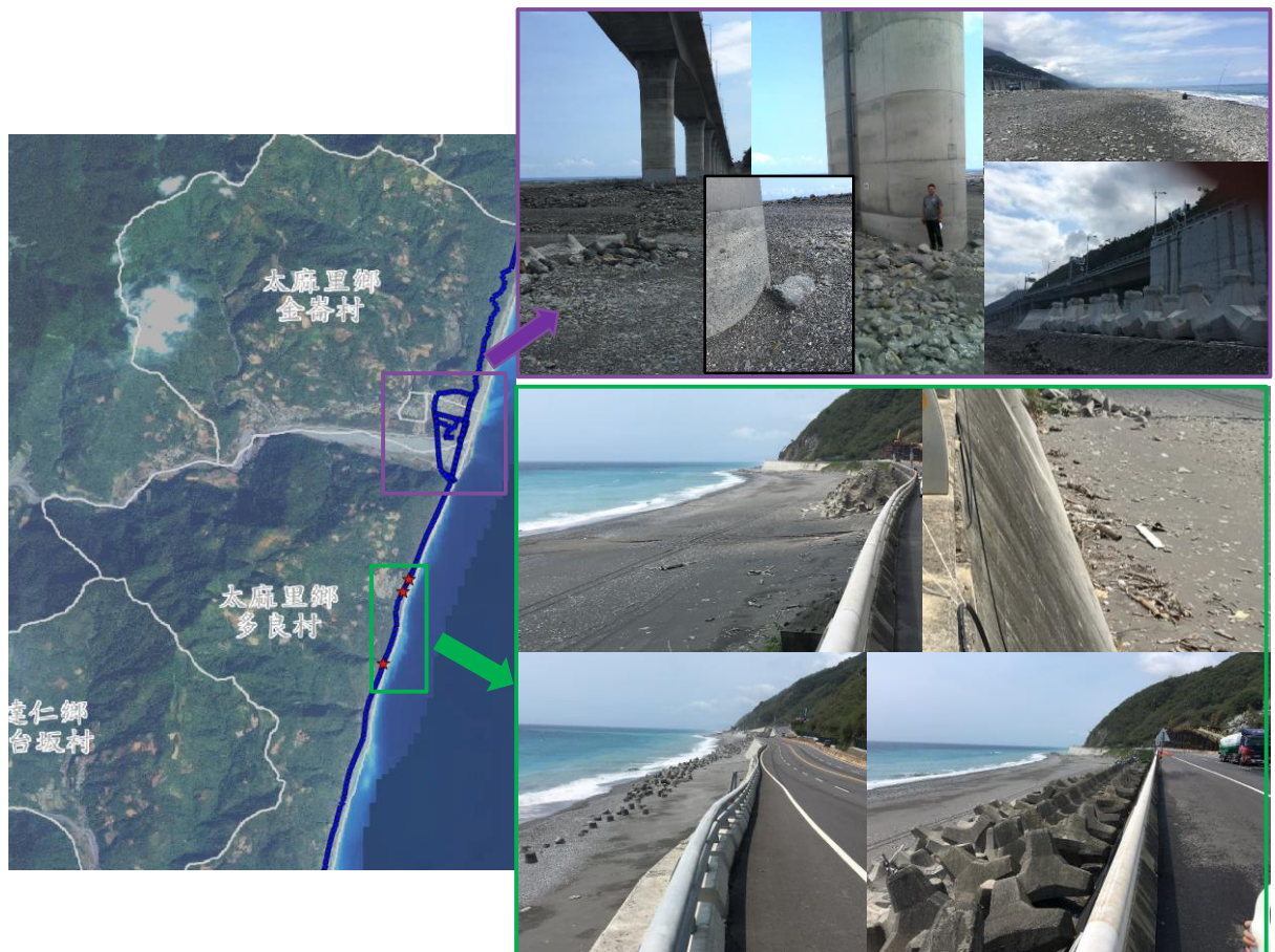
圖 2.7 多良路段與金崙大橋現勘成果圖(民國 107 年 4 月)
