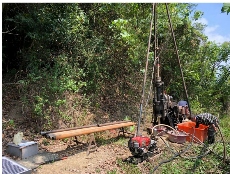
圖 5.4 道路上邊坡鑽探施工情形
