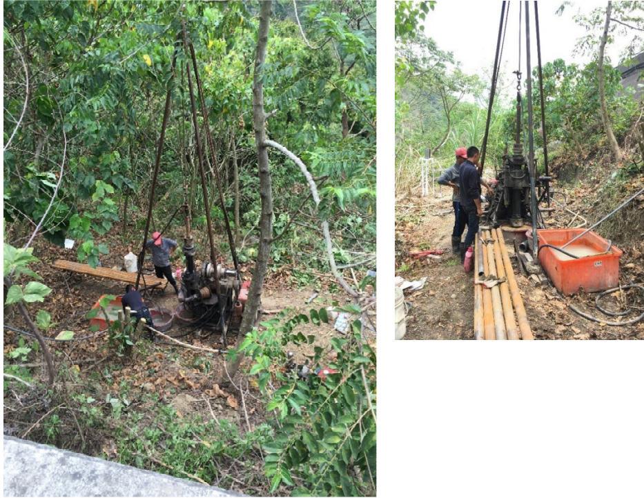
圖 5.5 道路下邊坡鑽探施工情形
