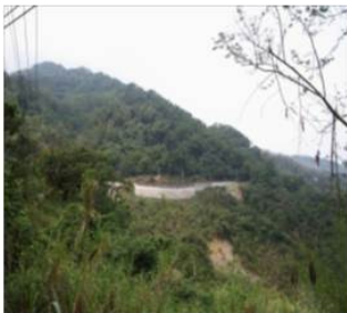
道路下邊坡淺層崩塌(青山工程顧問公司)
