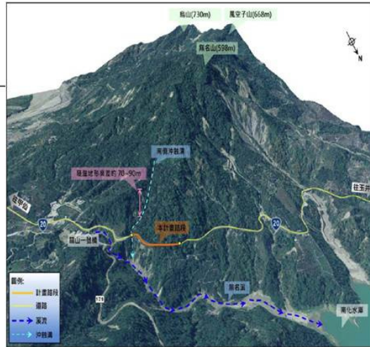
台20線邊坡地形圖(青山工程顧問有限公司)
