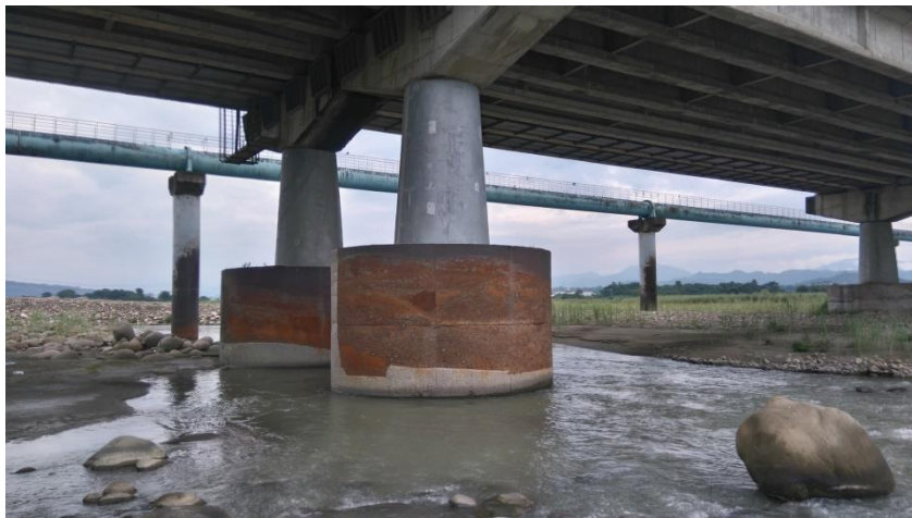
圖 6.2 南雲大橋之試驗墩柱 (墩柱 14)
