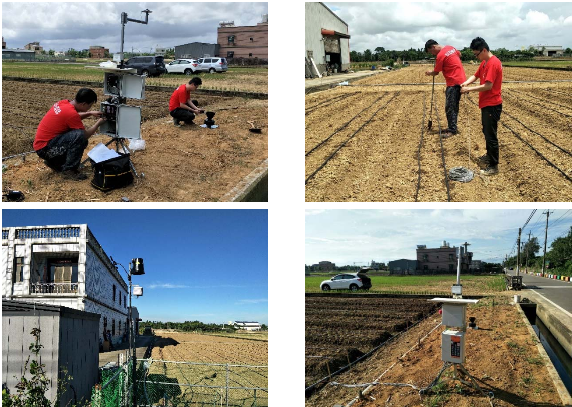
圖 4-4 氣象設備安裝情形
