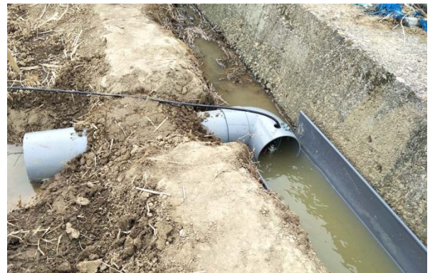
田區排水管暨自記水位計安裝
