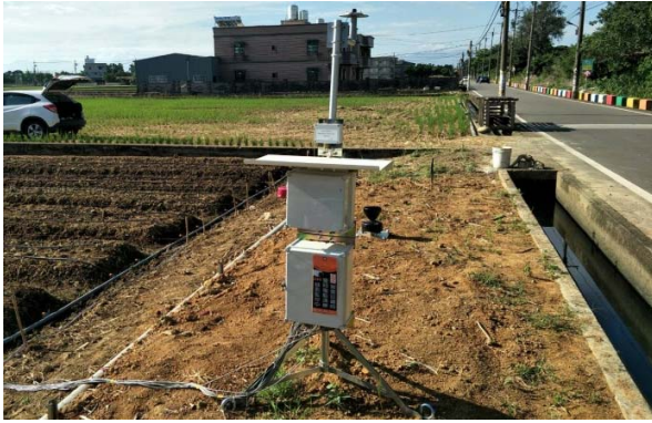
氣象站各項感測元件安裝完成
