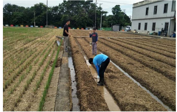
田區排水路挖掘
