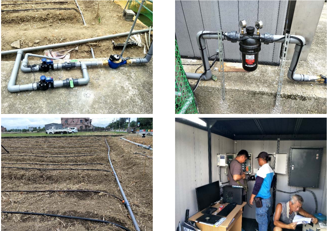
圖 4-5 灌溉系統安裝情形
