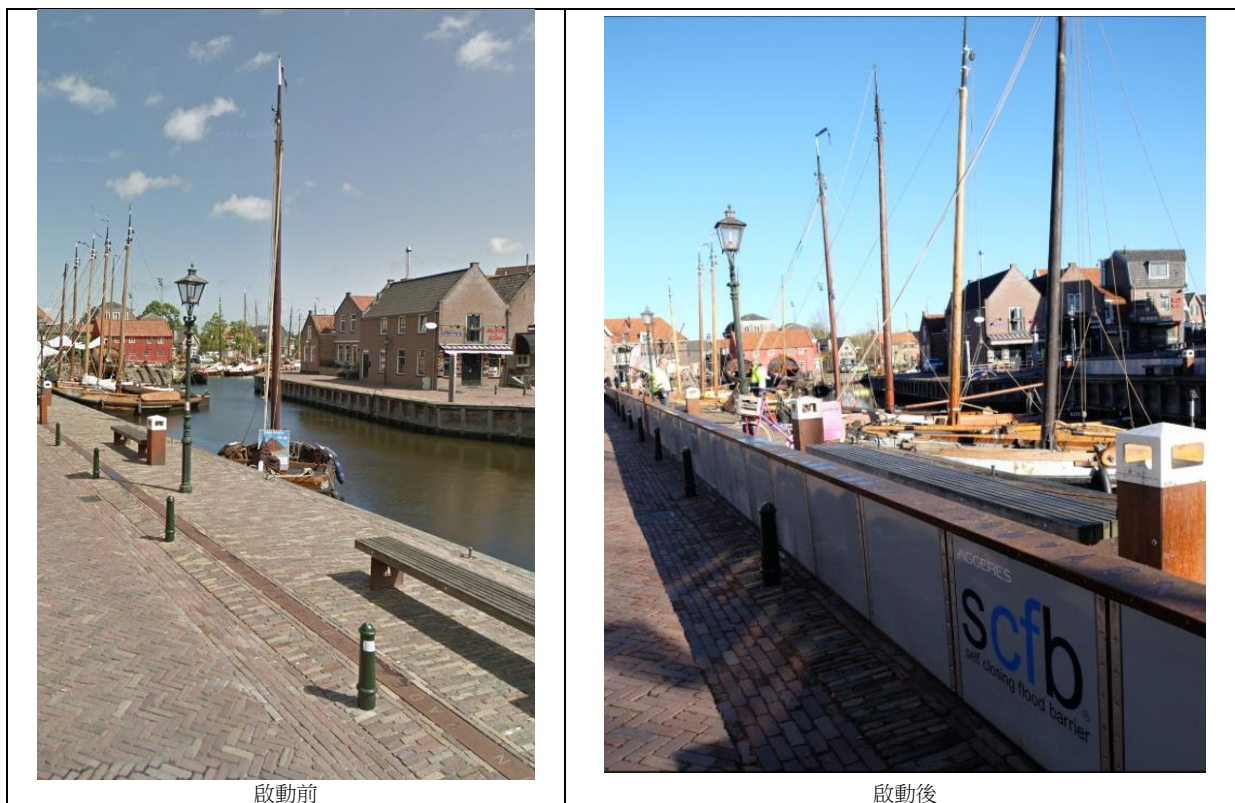
圖2-4-13 自動關閉洪水閘門啟動前後 12
