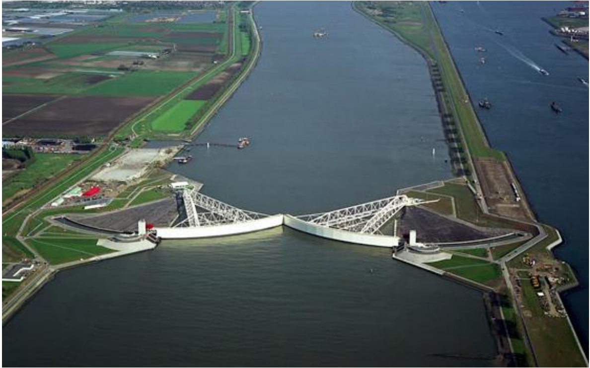
圖2-4-11 Maeslantkering風暴潮屏障
