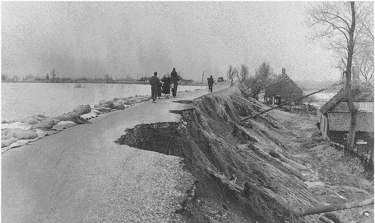
圖2-2-3 荷蘭1953年的洪水造成堤防毀損
