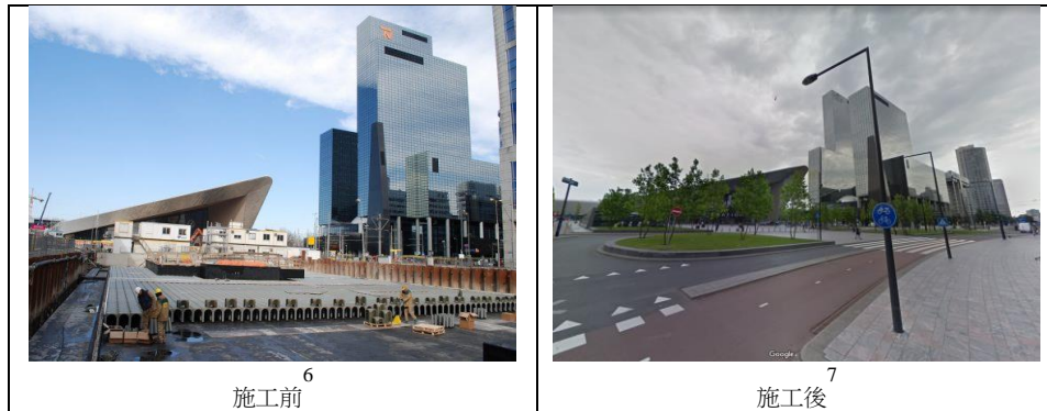
圖2-4-6 地下蓄水槽施工前後對比照
