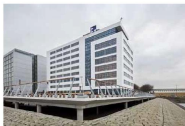
圖2-3-6 房屋基礎架高，防護結構
