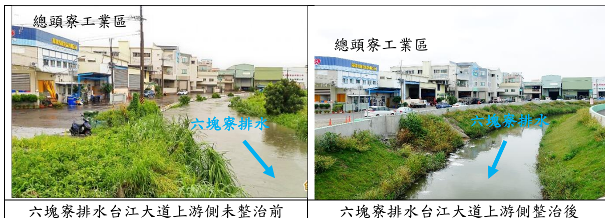
圖 3-6 總頭寮工業區鄰近排水路整治前後照片
