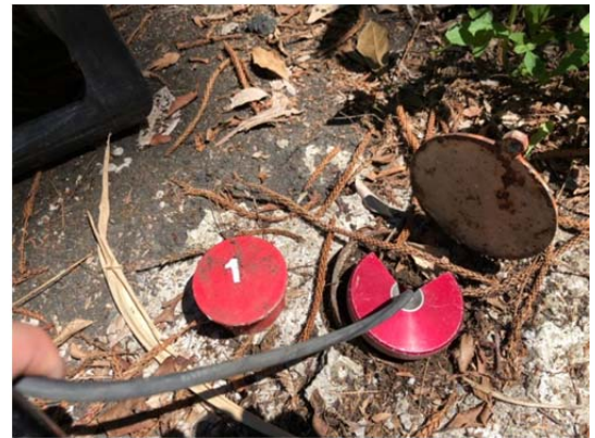
現場測傾管照片
