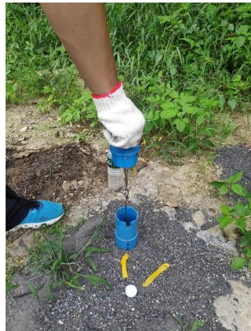
圖 4.1.2-16 108-D007-1W 水位計安裝完工實況
