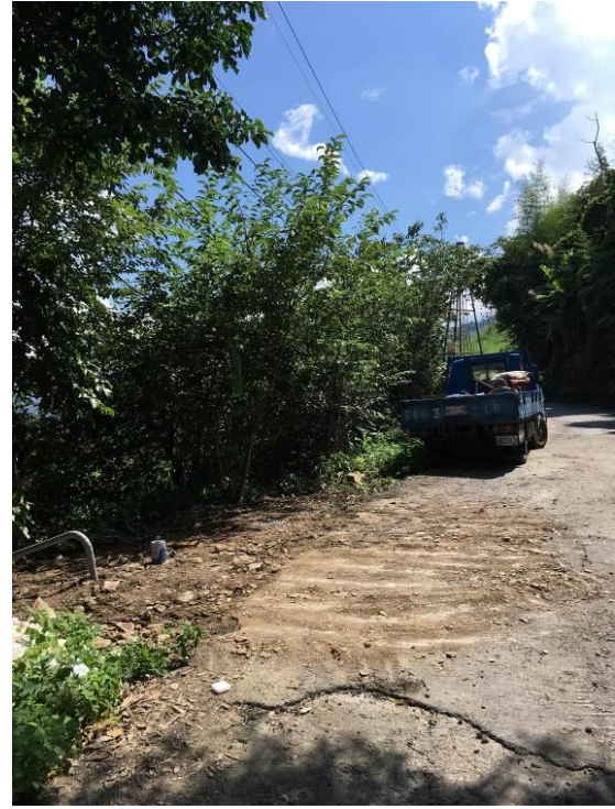
圖 4.1.2-11 108-D007-3T 淺層 含水量監測安裝完工實況
