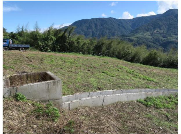
照片 5.場址內坡腹區的侵蝕溝上緣目前已有縱向排水溝
