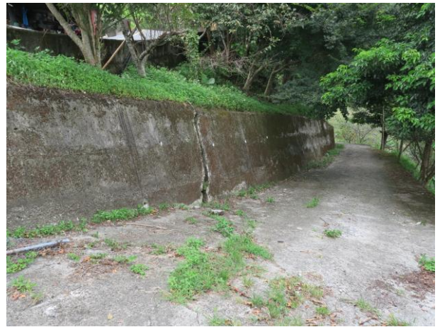
照片 15.場址西側往英士村的道路破壞
