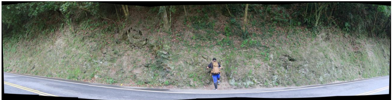
照片 16.坡址臨台七線因重力變形引致岩層位態混亂無一致性
