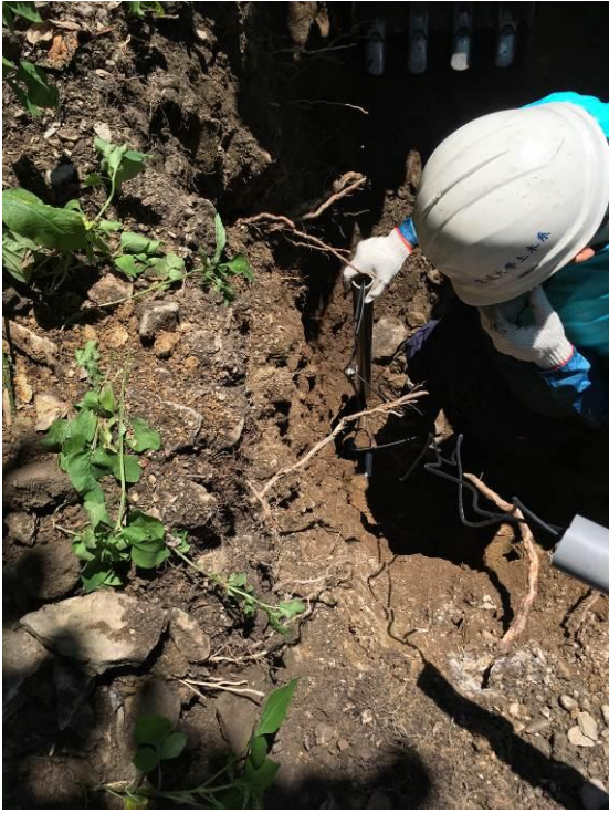
圖 4.1.2-10 108-D007-3T 淺層 含水量監測安裝過程實況
