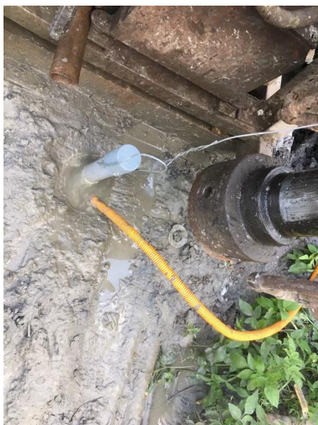
圖 4.1.2-6 108-D007-2T TDR 監測纜線安裝現況
