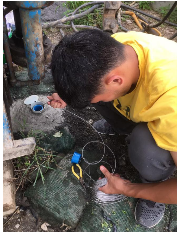
圖 4.1.2-18 108-D007-4W 水位計安裝完工實況
