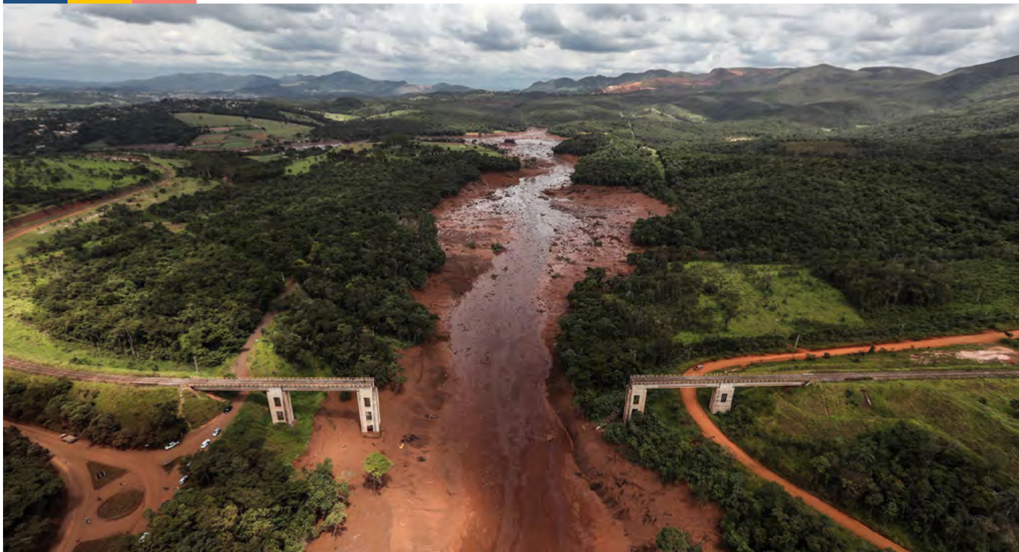
巴西布魯馬迪紐市因礦區崩塌夾雜大量泥水淹沒下游地區，造成鐵路橋梁破壞 (資料來源：歐新社 / 典匠資訊授權提供)
