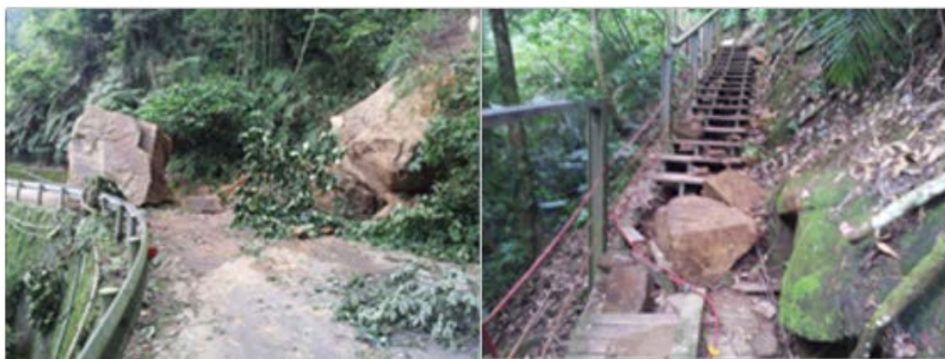
圖 3、天梯聯外道路與園區內落石坍方道路中斷
