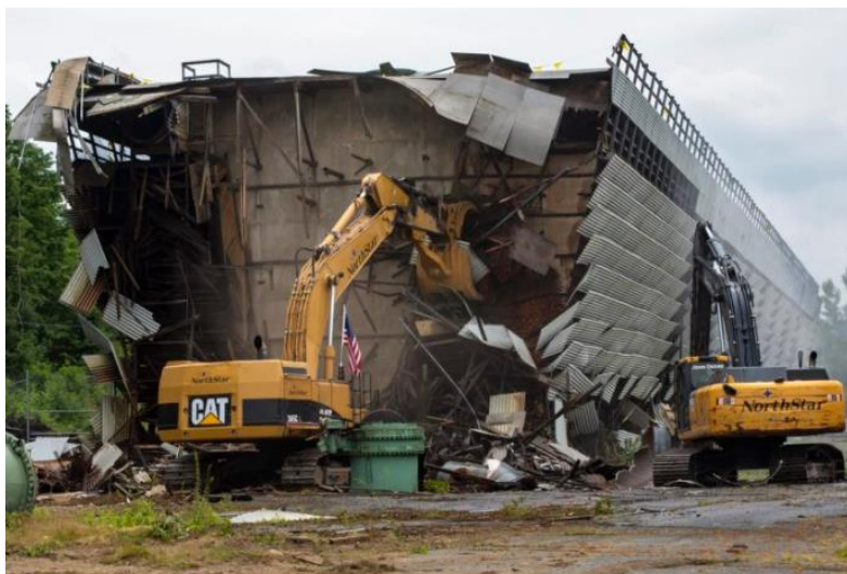
圖 8 VYNPS 一部份的水冷卻塔拆除照片 資料來源：VTDigger，2019
