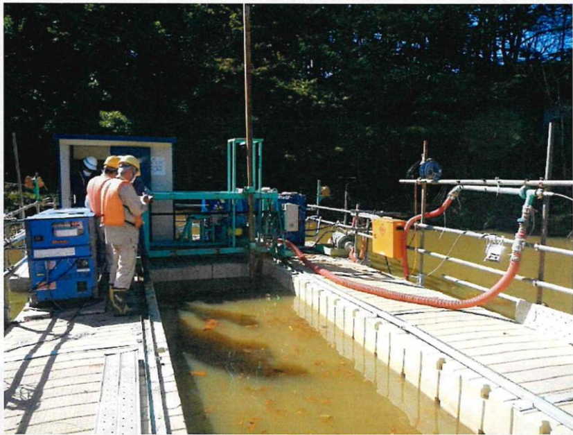
圖 49 清除灌溉池底部的污染泥土作業
